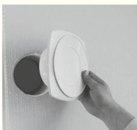
При монтаже необходимо учесть, что расположение клапана близко к оконному откосу может спровоцировать промерзание стены и образование конденсата, так как в этом месте температура поверхности стены понижена. Поэтому рекомендуется располагать клапан приточный на высоте верхней трети окна на расстоянии не менее 300 мм от оконного откоса с уклоном 3 - 5° в сторону улицы.
